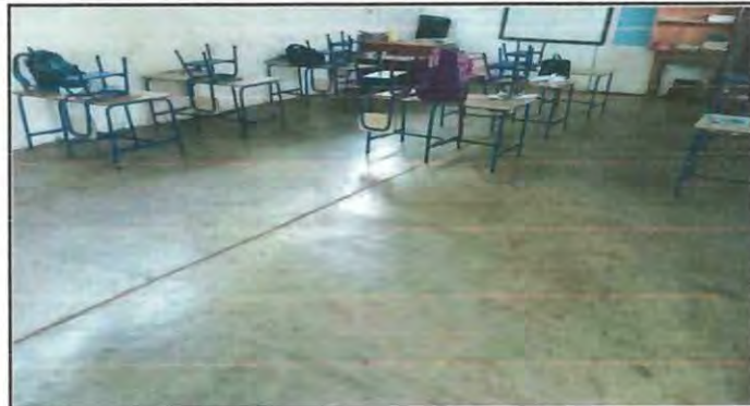
FOTO 8 Sustrucion de piso rustico a piso ceramico.
