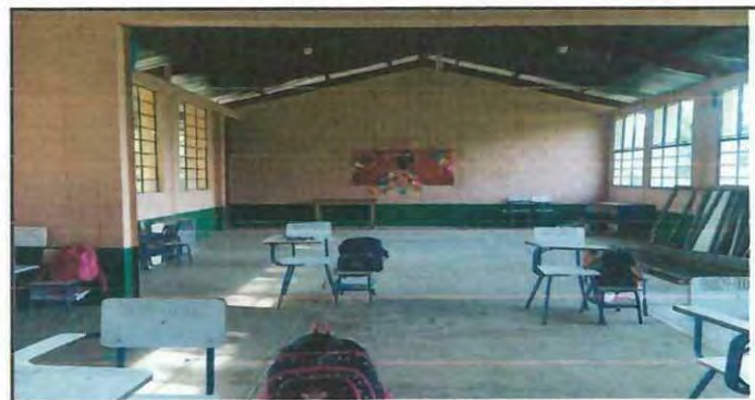
Foto 6: Colocacion de lamina fria para divisiones de aulas.
