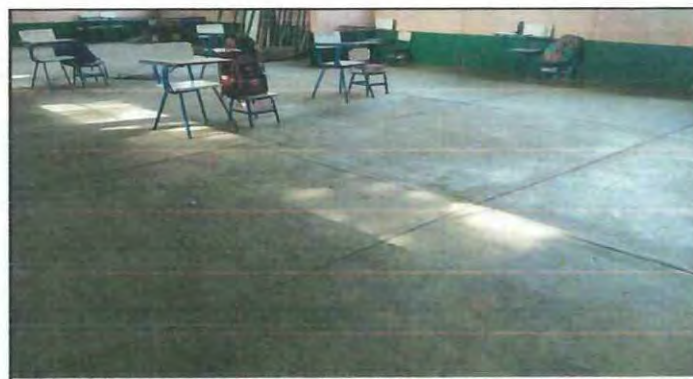
Foto 4: Sustitucion de piso rustico a piso ceramico.
