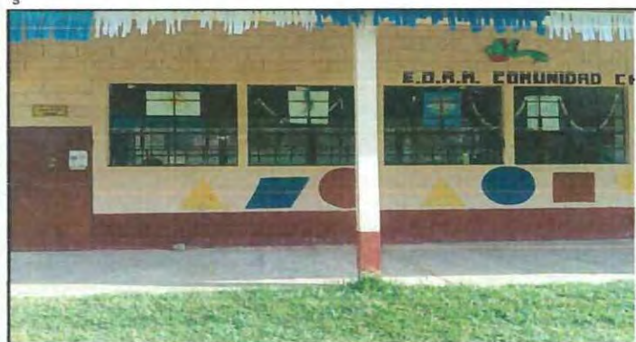
Foto 3: Pintura interior y exterior y pintura de puerta. Cambio de una chapa de puerta.
