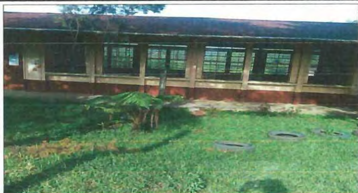
Foto1: pintura interior y exterior de aula 1 y 2
