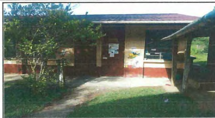
Foto 2: Pintura para direccion y para puerta
